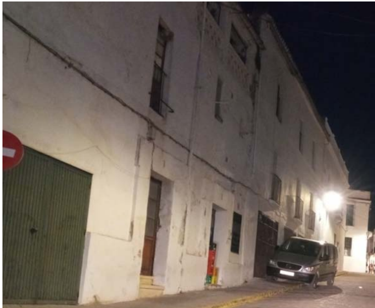
Foto 18 Viviendas con necesidades de rehabilitación en el CH
