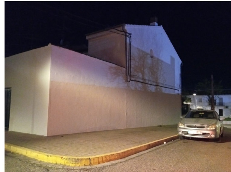
Foto 28. Muros ciegos en lateral de viviendas y acera sin rampa de acceso
