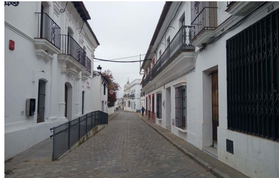
Foto 2. Edificio con acceso adaptado
