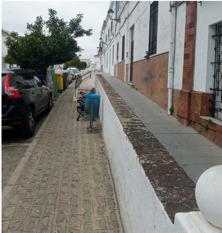
Foto 5. Acerado angosto, suelo inadecuado y obstáculos
