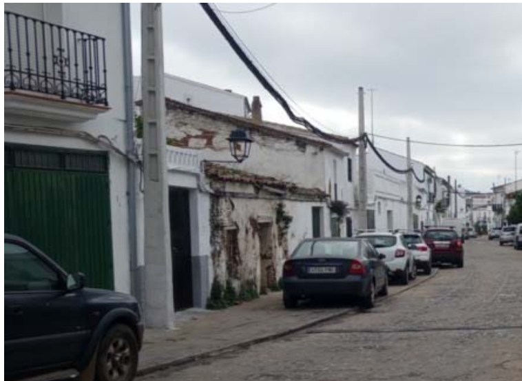
Foto 17. Edificaciones en ruina en CH
