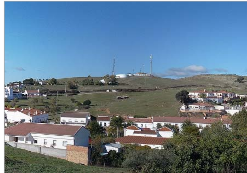
Vista general de los depósitos de agua.
