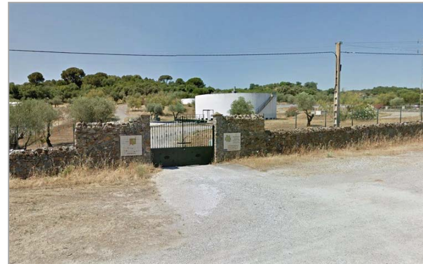
Vista de la estación depuradora de aguas residuales (EDAR).
