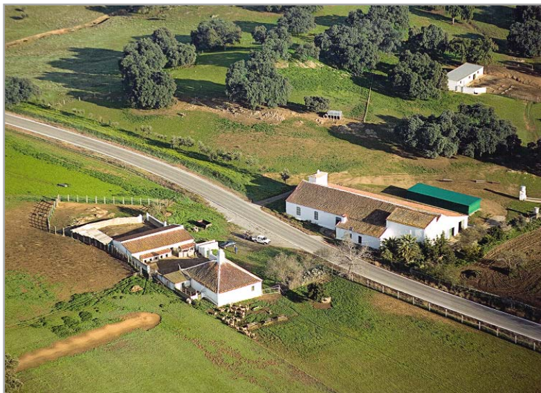
Vista aérea del Cortijo de Tres Vigas.
