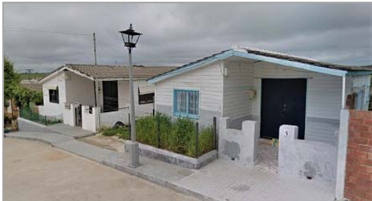
Infraviviendas. Casas prefabricadas en el entorno de La Recacha.
