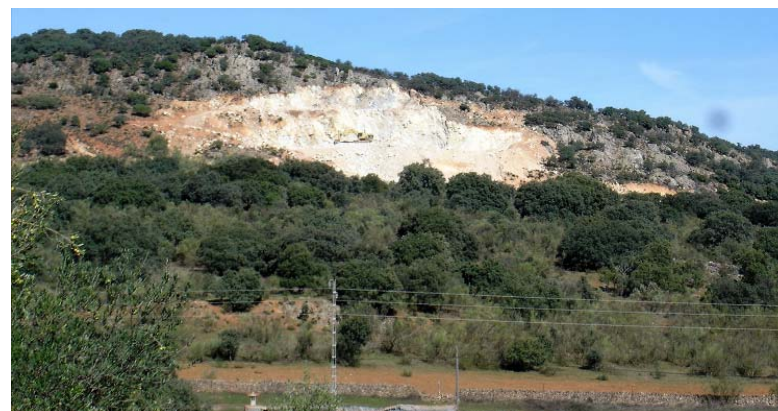
Vista de la cantera de Ostalé en el paraje de Realejo, junto al Cementerio municipal.
